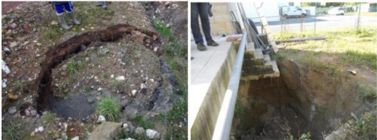
Figure 2. Exemples d'effondrements localisés au droit de cavités d'origine anthropique – source : Ineris
